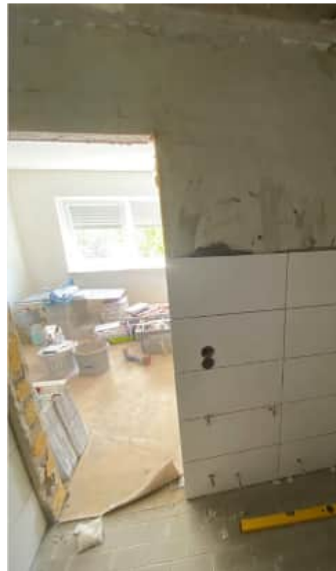
Bild: Blick in die Baustelle für das neue Büro des Gemeindeförsters
