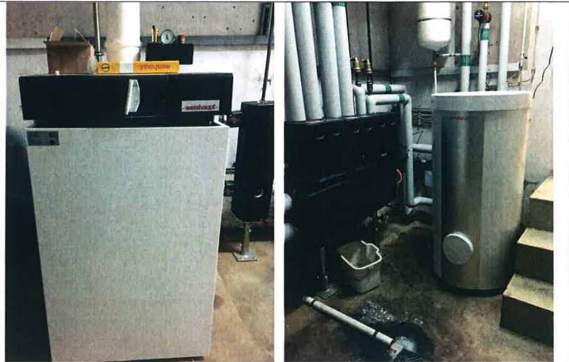
Abbildung 6: Neuer Gas-Brennwert Kessel mit neuem Trinkwarmwasser-Speicher im Rathaus Rohrau
